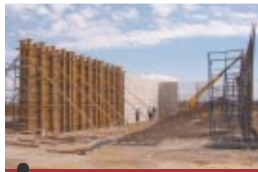
Concreto autoconsolidable con aditivo PLASTOL 4000 en Mexcatitlán, Edo. de México (Concretos Holcim Apasco).
