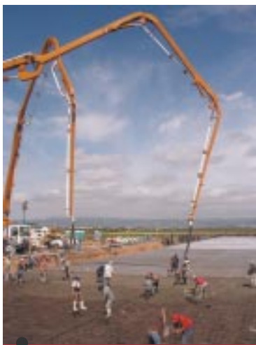
● Concreto Masivo con aditivo PLASTOL 4000. Frigorífico en Aguascalientes (Concretos Cruz Azul).
