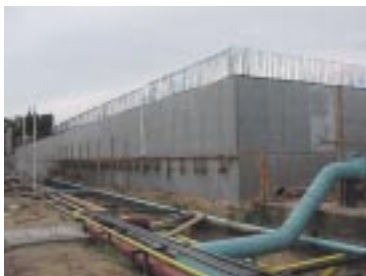
● Concretos de baja permeabilidad con EUCON MSA y EUCON 537 en Tuxtepec, Oaxaca (Grupo Modelo).
