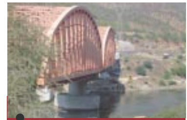
Concreto bajo el agua con aditivo EUCON AWA. Reparación de puente en Autopista Uruapan-L. Cárdenas. (Concretos Holcim Apasco).
