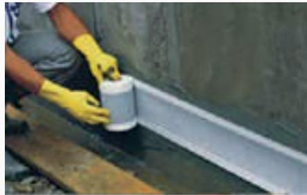
2 Recubra VANDEX CONSTRUCTION JOINT TAPE con una segunda capa de VANDEX CEMELAST (3Kg/m2, 1.5 mm).
