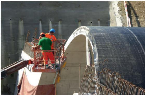
Impermeabilización de cara externa con VANDEX CEMELAST
