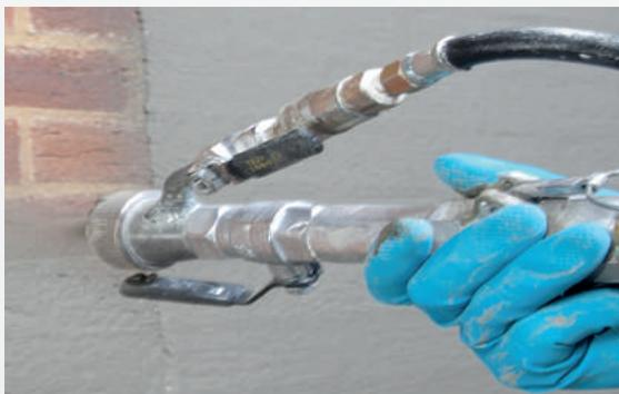
Impermeabilización de cara interna con VANDEX CEMELAST
